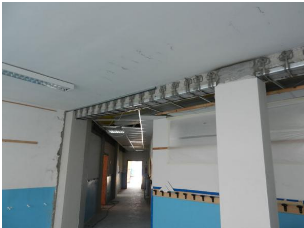
Figura 6 – Esempi tipo di rinforzo con sistema di cuciture attive su travi
