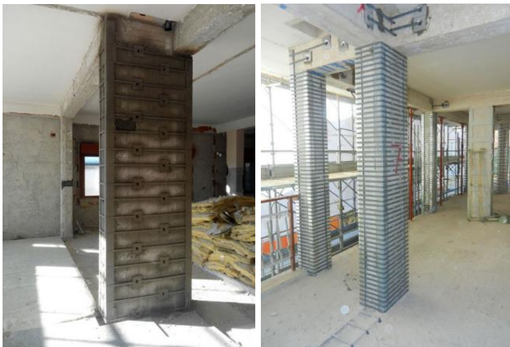
Figura 7 – Esempio tipo di rinforzo con sistema di cuciture attive su pilastri
